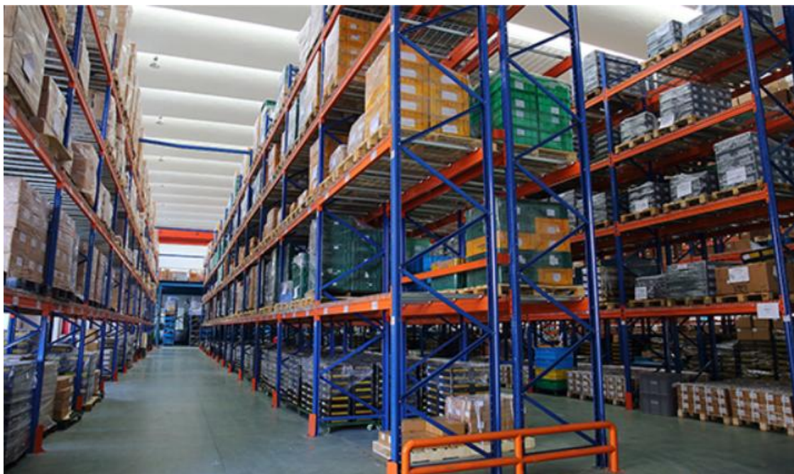
附图 3-10 超力电器-智能物流仓储系统
