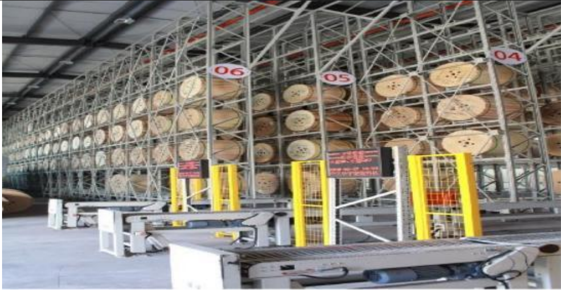
图 62-电缆智能立体库
